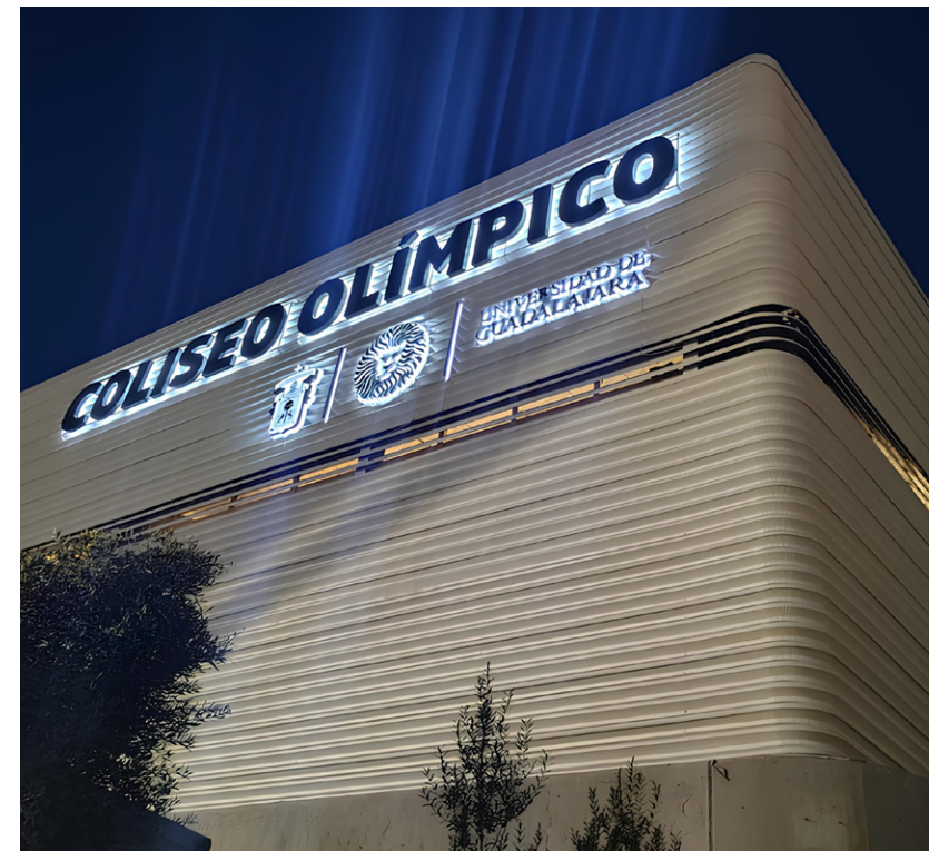
Exterior del Coliseo Olímpico
